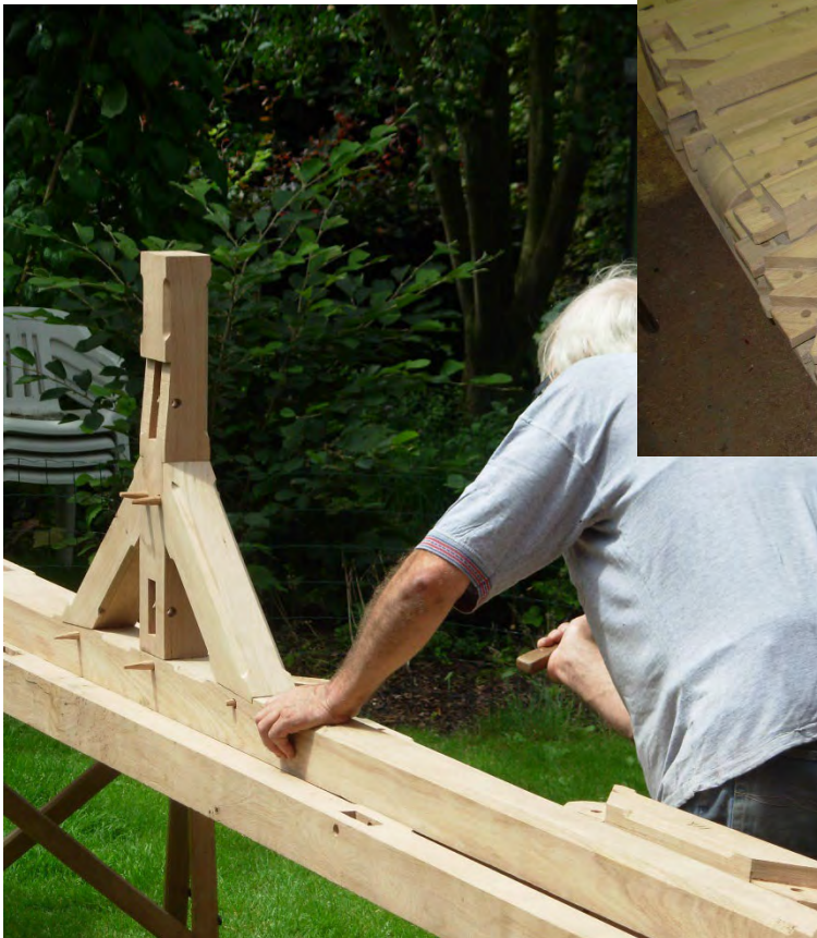
Eikenhouten berging voor stookhout met 64 pen-gat houtverbindingen, vergaard met toognagels. Foto: Dany de Vooght, 2007
