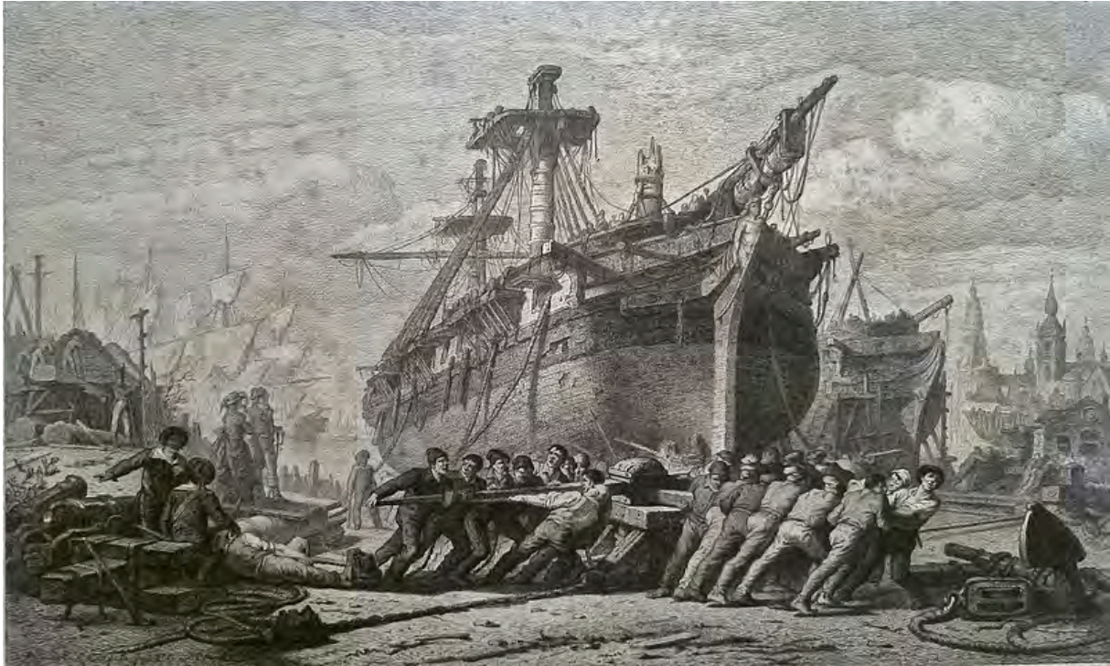
Voor herstellingswerk wordt een groot zeilschip de sloopshelling op getrokken met een enorme kaapstander en zware katrollen met meerdere wielschijven. De links op de grond liggende man houdt het touw gespannen en moet het doorslippen op de kaapstander as voorkomen. Napoleontische scheepswerf ter hoogte van de voormalige Sint Michielsabdij te Antwerpen. Gravure van 1804. Bron: Wikimedia.
