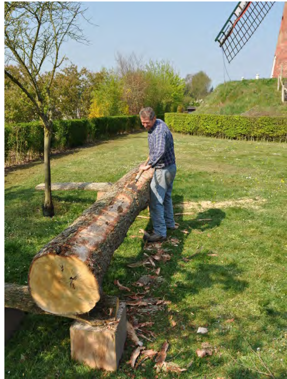
Afschrijven van de balkvorm op de koppen met schietlood vouwmetr en winkelhaak. Ontschorsen van de stam ter hoogte van de smetlijn.
