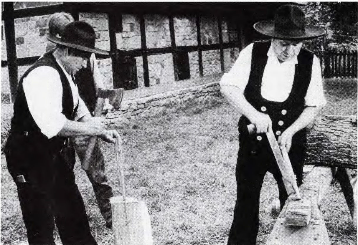
Abb. 29 Die Herstellung von Holznägeln mit Beil und Stoßaxt (für Schulfernsehaufnahmen im Westfälischen Freilichtmuseum Detmold).
