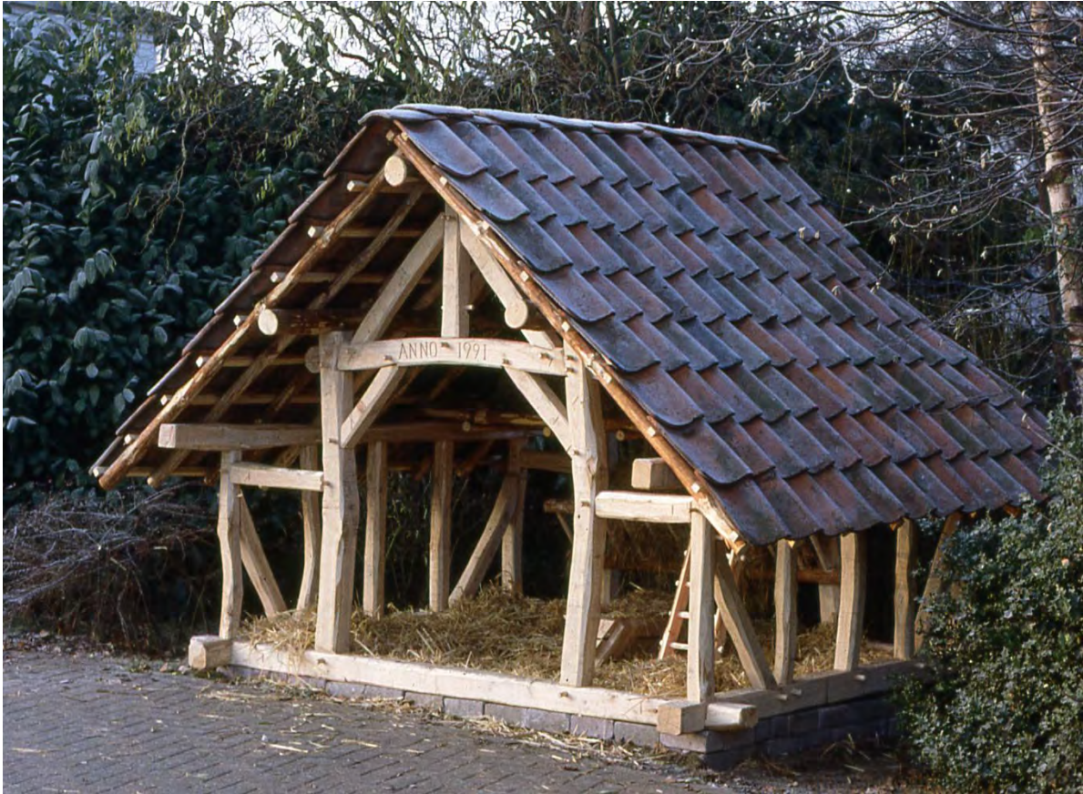
Kerststal, gebouwd in 1991 met kinderen van MPI Ritmica in Hove. De vakwerkconstructie bestaat uit tamme kastanje en de pen-gat verbindingen zijn opgesloten met toognagels.
