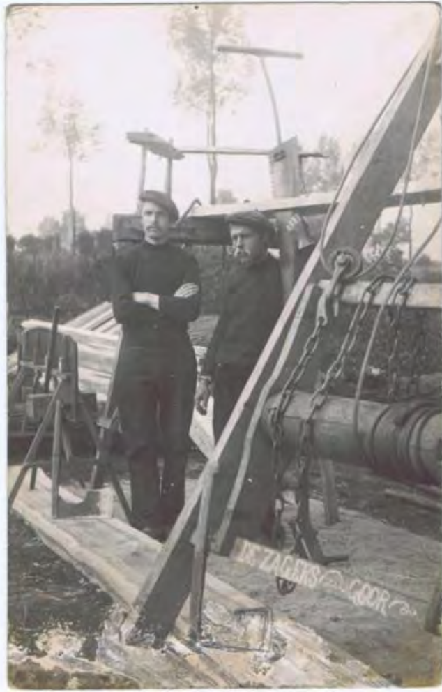
Schrank opgesteld bij een zaagstelling van berdzagers. Goor- Heist-op-den-Berg. Heemkring Die Swane, Heist-op-den-Berg
