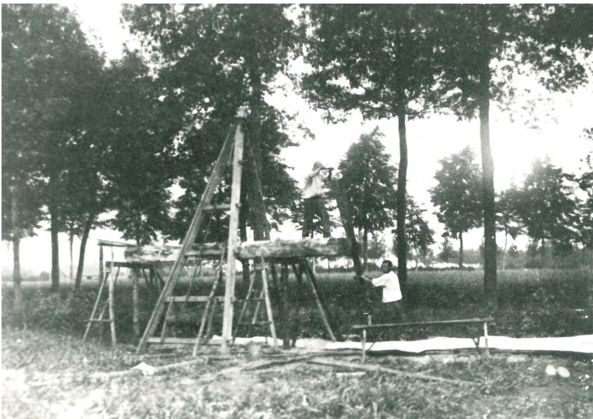
Zaagstelling met driebenige schrank in Herenthout Heemkring Sandelyn van Herenthout
