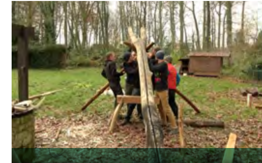
Om een zware mik rechtop te zetten zijn voldoende mankracht en hulpmiddelen nodig. (Foto MOT.)
