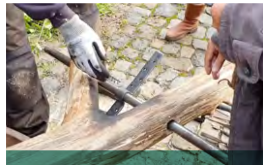
Het scharnier moet goed om de as kunnen draaien. (Foto Voorkempen.)
